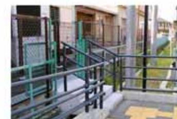
隣接の店舗敷地とホームとの直結
