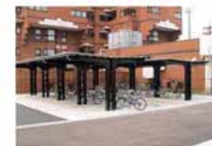
駐輪場の整備
