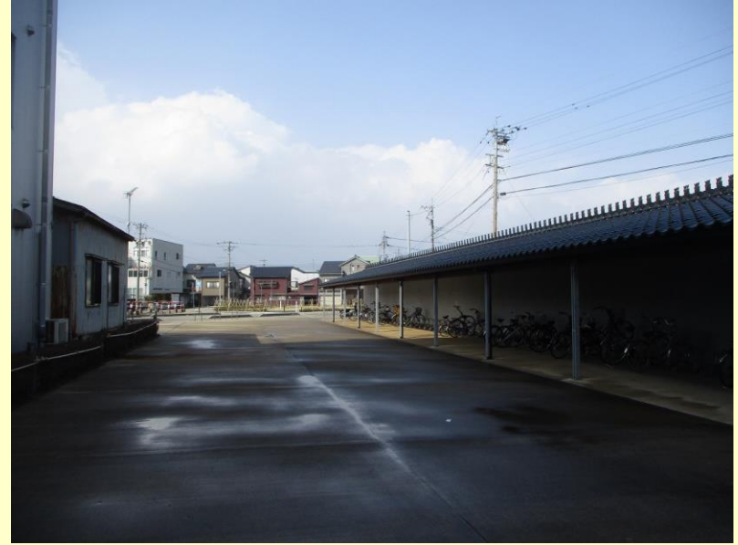
氷見駅延伸北側 駐輪場から道路へ
